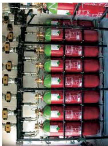
Impianto a gas chimici (es.: HFC-23)
