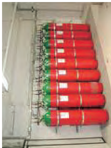
Impianto a gas inerti (es.: argon IG-02)
